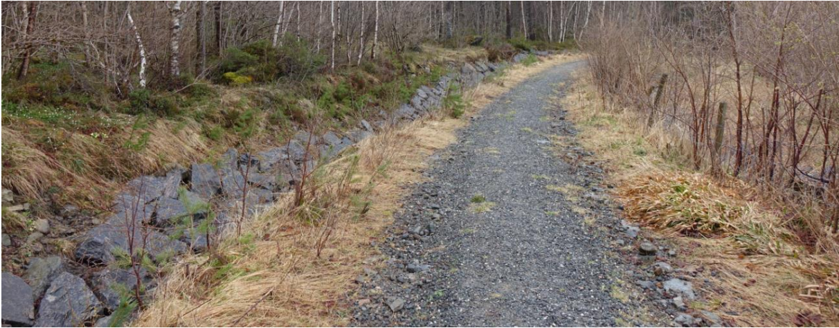
Figur 7: Yttergrensen av planområdet i øst. Her er det grøft på begge sider av turstien som drenerer overflateavrenningen fra fjellsiden.
